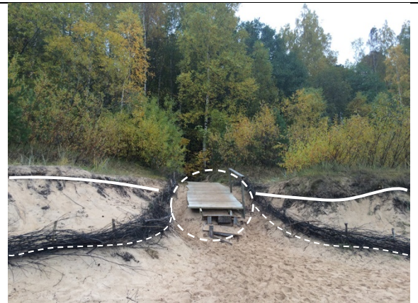
6 – Koka laipa ar daļēji sagruvušām kāpnēm uz pludmali – saglabājama un atjaunojama. Pīti žodziņi abās pusēs kāpnēm – saglabājami un veidojami divos līmeņos. Foto: E. Alle
