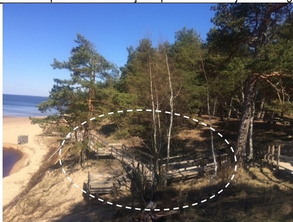
10 – Koka laipa/pandus uz pludmali. Īstermiņā saglabājams. Katru gadu novērot erozijas ietekmi uz pandusa konstrukciju atbilstību drošības normām. Foto: E. Alle
