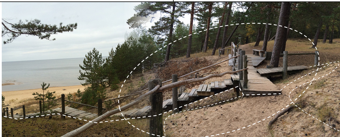
9 – Koka platforma un kāpnes noejai uz pludmali – atjaunojamas un ierīkojama lielāka platforma kāpņu augšdaļā. Izmīdīts laukums pie platformas – Saulrieta taka veidojama no koka laipas ar norobežojošām margām. Foto: E. Alle
