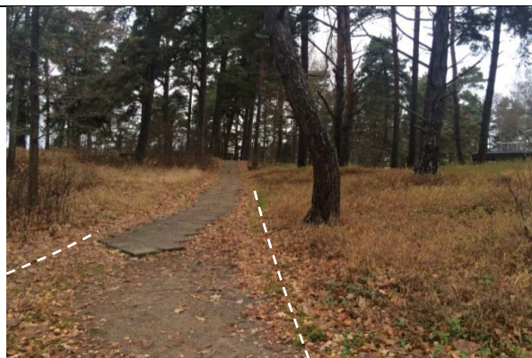
4 – Esošs betona plākšņu iesegums – aizstājams ar koka laipu. Īstermiņā saglabājams, ilgtermiņā demontējams. Takas malas norobežojamas, lai neveidojas nostaigātas malas. Foto: E. Alle
