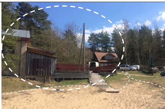
23 – Skats no pludmales uz Katrīnbādi. Noeja uz pludmali labiekārtojama, atjaunojot esošo koka laipu. Katrīnbādes ēkas fasādes atjaunojamas. Foto: E. Alle
