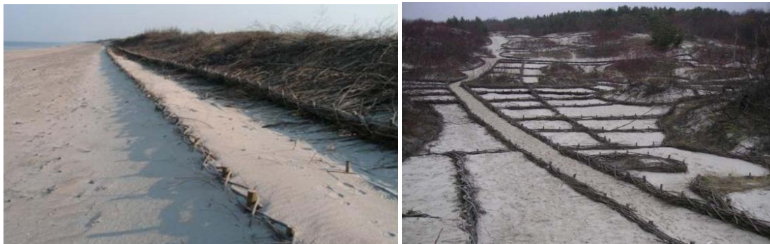
12. att. Zemu kārklu zaru pinumu/sētiņu, kārklu spraudņu un zaru pārklājumu izmantošana eolās akumulācijas veicināšanai un deflācijas novēršanai kāpas frontālajā daļā (attēls kreisajā pusē) un deflācijas mazināšana/atpūtnieku plūsmas organizēšana starpkāpu ieplakās (attēls labajā pusē). 2007. gads, Lietuva. Foto: D. Pupienis
