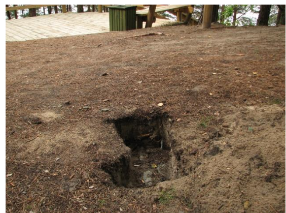
1.1.18.att. Prototipa elementu izbūve vietās, kur zemesdzīvībā neklāj veģetācija.
