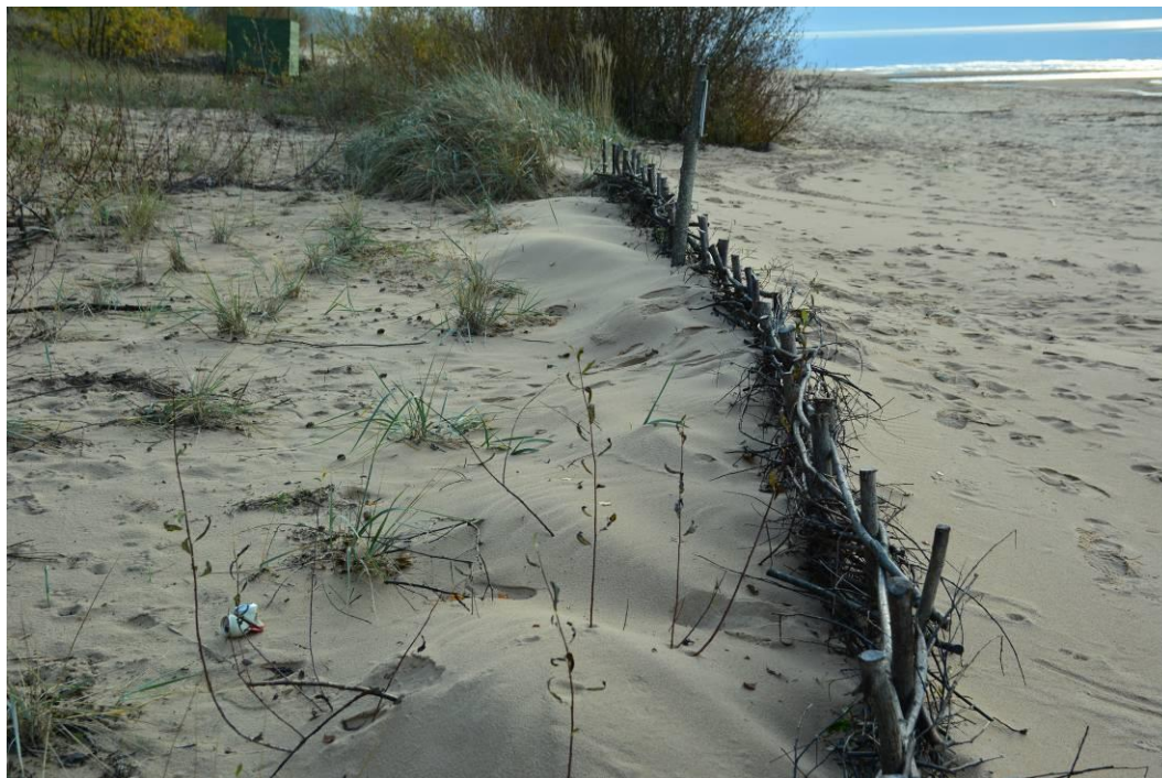
14. Attēls. Primārās kāpas atjaunošanas eksperimenta teritorijas ziemeļu daļa 2017. gada oktobrī (skats uz dienvidiem). Smilšu akumulācijas rezultātā lielākā daļa no kārkļu pinuma žoga ir apbērtā. Attēla kreisajā pusē redzami arī kāpu graudzāļu stādi, kuru izdzīvošanas sekmes pārsniedz 90 %.
