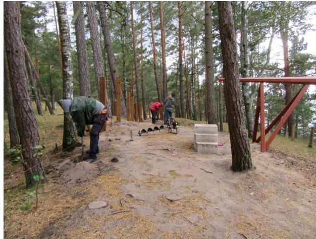
1.1.15.att. Pēc DDP "Baltā kāpa – Saulkrasti" elementa izbūves zemsedze ārpus takas sāk atjaunoties (2019.g.septembris). Jaunās laipas (projekts "Jūrtaka") būvniecības darbu laikā zemsedze tiek ietekmēta atkārtoti.
