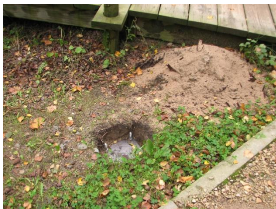
1.1.17.att. Prototipu elementu izbūvei tiek izmantotas metodes, kas esošo zemsedzi skar tikai pamatu daļā 24cm x 24cm lielā laukumā.
