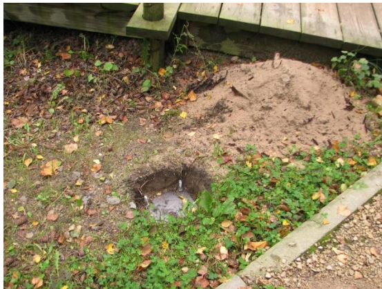
1.1.9.att. Prototipu elementu izbūvei tiek izmantotas metodes, kas esošo zemsedzi skar tikai pamatu daļā 24cm x 24cm lielā laukumā.
