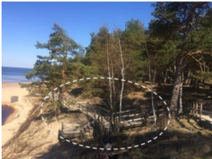
22 - Esoša koka laipa/pandus uz pludmali. Īstermiņā saglabājams. Katru gadu novērot erozijas ietekmi uz pandusa konstrukciju atbilstību drošības normām. Foto: E. Alle
