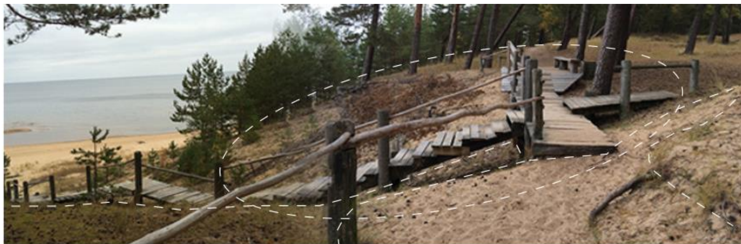
17 - Koka platforma un kāpnes noejai uz pludmali – atjaunojamas un ierīkojama lielāka platforma kāpņu augšdaļā. Izmidīts laukums pie platformas – Saulrieta taka veidojama no koka laipas ar norobežojošām margām. Foto: E. Alle
