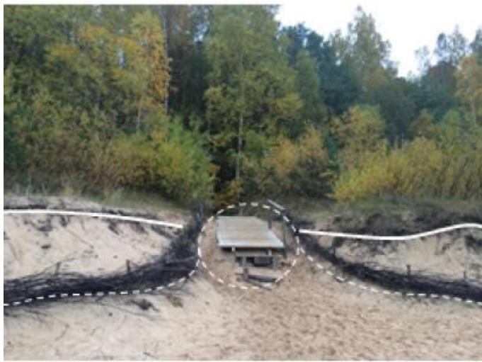
20 - Esoša koka laipa ar kāpnēm uz pludmali – atjaunojama. Pīti žodzīņi abās pusēs kāpnēm – saglabājami un veidojami divos līmeņos. Foto: E. Alle
