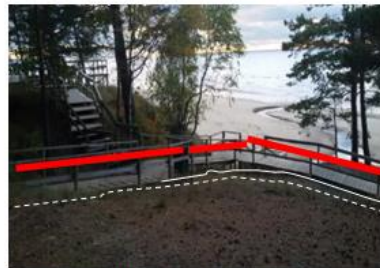
④ Margas veicina nobradājumu, smagās konstrukcijas aizēno Inčupes "kaķa izliekumu"
